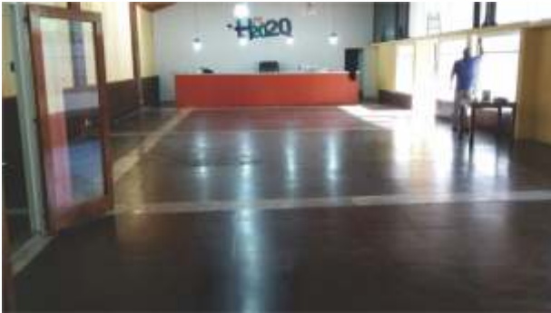
REMDELACIÓN COMPLETA SALÓN 1º PISO EX RESTO
