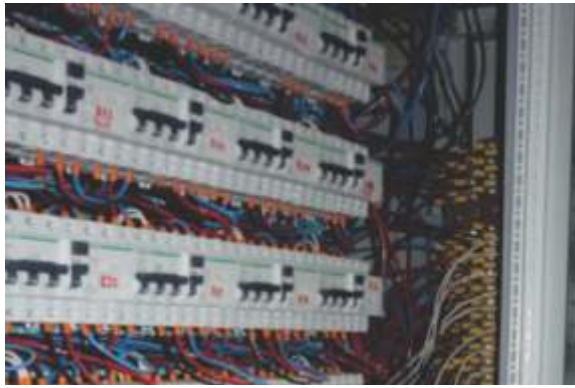
COLOCACIÓN DE CÁMARAS DE ELECTRICIDAD EN VARIOS LUGARES CON LLAVES DE SEGURIDAD
