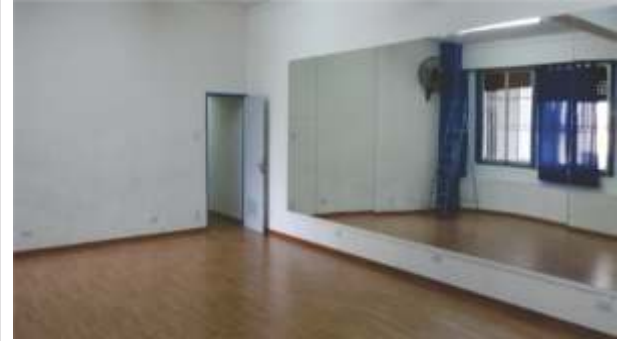
COLOCACIÓN DE PISO FLOTANTE Y ESPEJOS SUM IV
